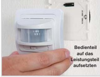
Bedienteil auf das Leistungsteil aufsetzen
